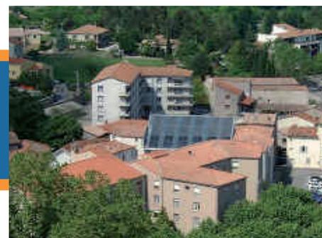
Installation solaire thermique pour la production d'eau chaude sanitaire collective. Mise en service en 1983, elle assurait le préchauffage de l'eau de la piscine de rééducation. En 2000, l'installation est redimensionnée et affectée à la production d'eau chaude sanitaire pour les occupants des 80 chambres et les salles de bains collectives.
