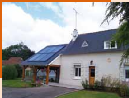
> Capteurs thermiques intégrés en toiture secondaire (Chauffage)
