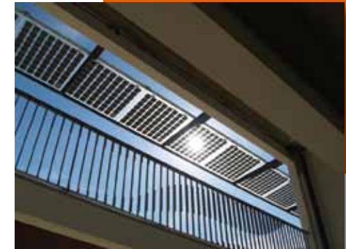
> Capteurs photovoltaïques en brise-soleil
