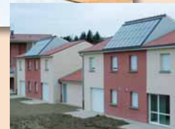
> Couverture totale en capteurs solaires thermiques (Chauffage)
