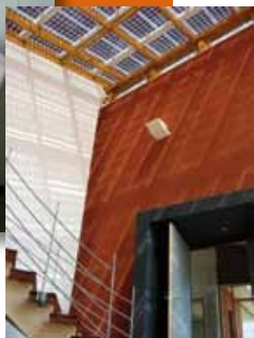
> Capteurs photovoltaïques semi-transparents en verrière
