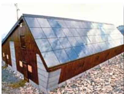
> Toiture complète en photovoltaïque
