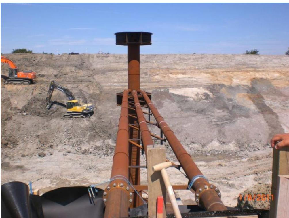
Figure 7. Mise en œuvre des diffuseurs lors de la construction du PTES de Marstal (source : Marstal Fjernvarme)
