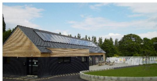
Sur ce camping du Morbihan, les 42 m<sup>2</sup> de panneaux solaires thermiques installés en 2011 permettent à la fois de chauffer le bâtiment d'accueil et de fournir en eau chaude tous les blocs sanitaires du camping. En présaison, ils permettent même de chauffer l'eau de la piscine.
