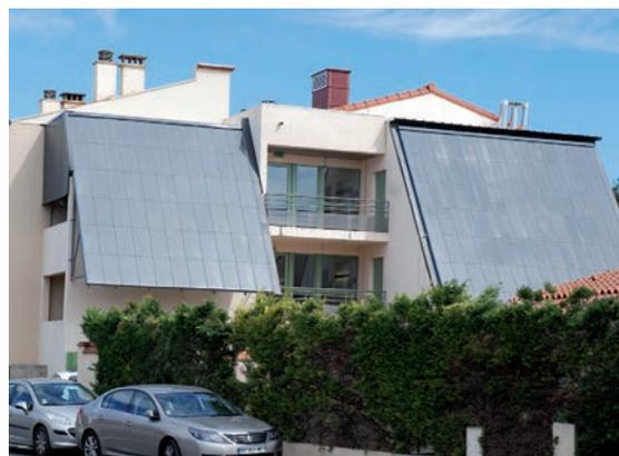
Capteurs solaires installés sur l'avancée de toiture de l'extension de bâtiment au Mas d'Agly
