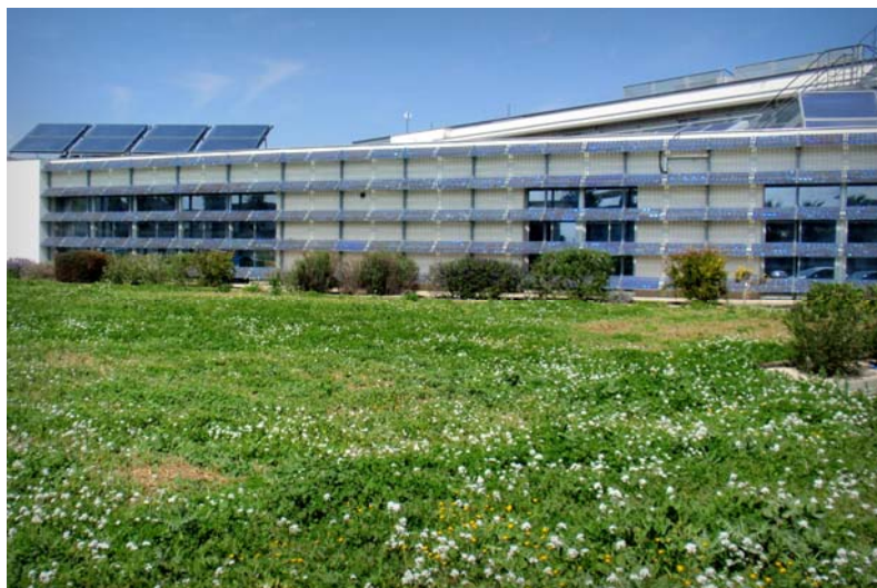
Photo(s) du bâtiment : Laboratoire PROMES – CNRS à Perpignan
