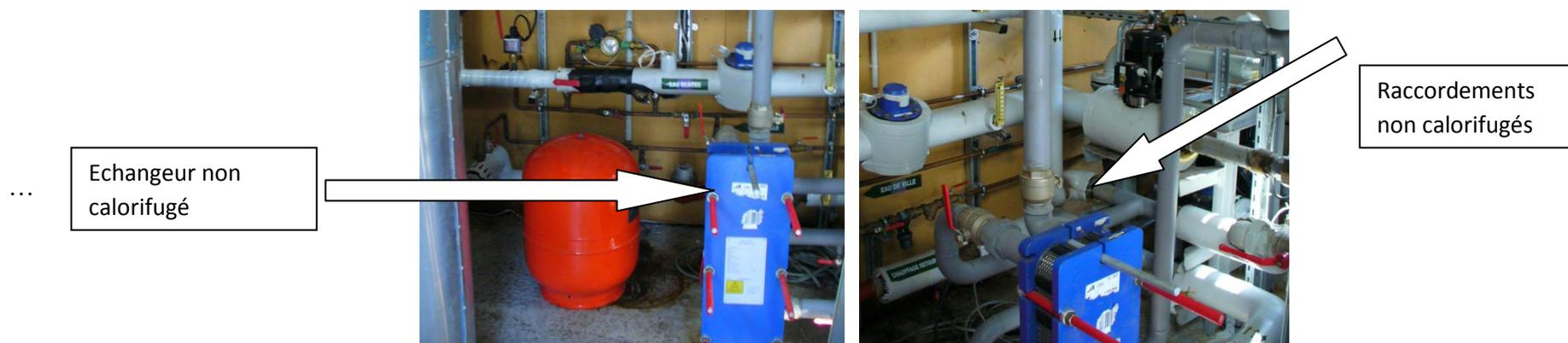
Figure 15 – Plan de maintenance – échangeur de chaleur
