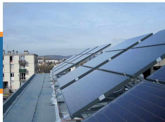
La Soval, SA d'H.L.M. du Val de Seine, a anticipé dans son projet de rénovation de la cité des Belles Côtes la mise en place d'une installation solaire thermique de production d'eau chaude. Ainsi elle a pu lancer parallèlement la mise en place d'une production d'eau chaude et la réfection de la toiture terrasse du bâtiment. Ceci a permis de réduire les coûts d'investissement et d'optimiser l'espace disponible en toiture.
