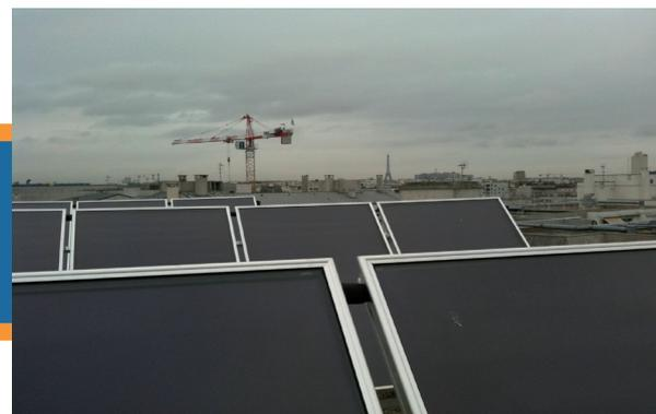
*Installation solaire thermique autovidangeable pour la production d'eau chaude sanitaire collective*
