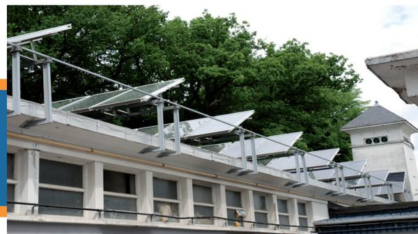
Installation solaire thermique autovidangeable pour la production d'eau chaude sanitaire
