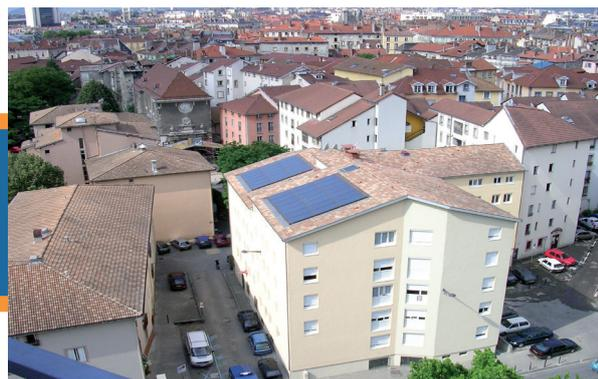
Rénovation d'un ensemble de 80 logements travailleurs immigrés. Programme global de réhabilitation, chauffage, ventilation, production et distribution d'eau chaude sanitaire. La production d'ECS était assurée par un préparateur semi-instantané de type HOVAL alimenté par le chauffage urbain. Une installation solaire de production d'ECS a été installée et le préparateur a été gardé en appoint.
