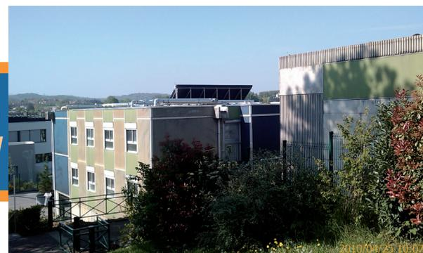
Rénovation d'un ensemble de logements pour jeunes travailleurs. Programme global de réhabilitation (accessibilité, chauffage, ventilation, production et de distribution d'eau chaude sanitaire). Dans chaque bâtiment, l'eau chaude sanitaire électrique existante a été abandonnée et remplacé par une production d'eau chaude sanitaire mixte gaz + solaire thermique par champs de capteurs installés en toiture terrasse.
